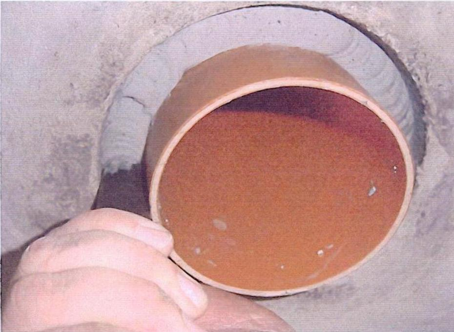
Bild 3: Fehlstellenfreie Applikation der Dichtmasse *KB-Flex 200* in den Ringspalt
