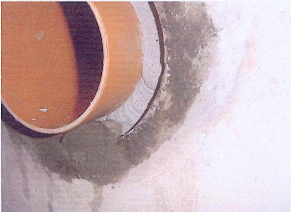
Bild 4: Raumseitiger Verschluss des Ringspaltes mit Schnellzement *KB-FIX 5*
